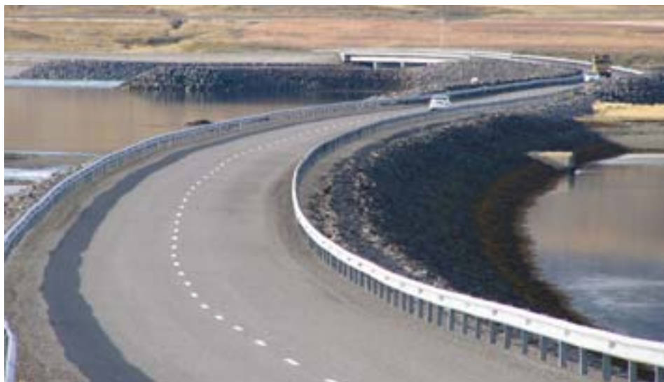
Kolgrafarfarðarbrú. Nýlegt vegamannvirki og frágangur til fyrirmyndar
